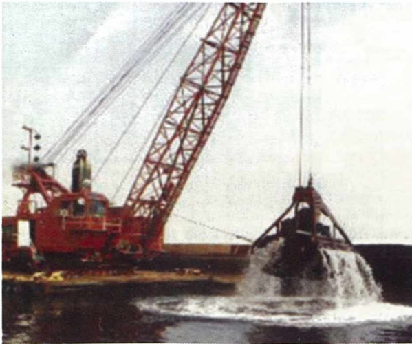
Şekil 5. Gölde sediment uzaklaştırılması
